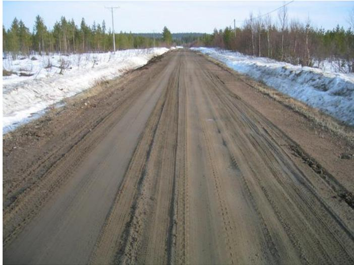
Figura 13: Ormaie in una pavimentazione granulare
