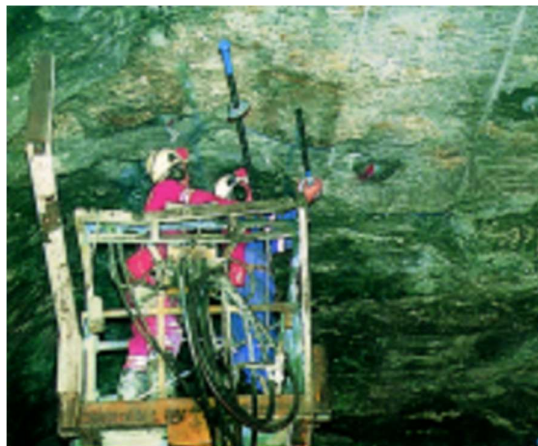
Fig. 4.8 Installazione dei bulloni sulla volta del tunnel
