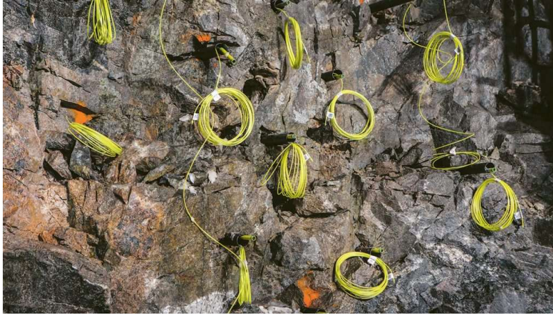
Fig. 4.3 Posizionamento esplosivi nei fori
