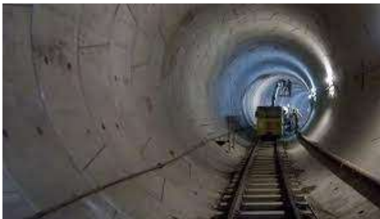
Fig. 4.11 Tunnel realizzato con TBM ed elementi prefabbricati
