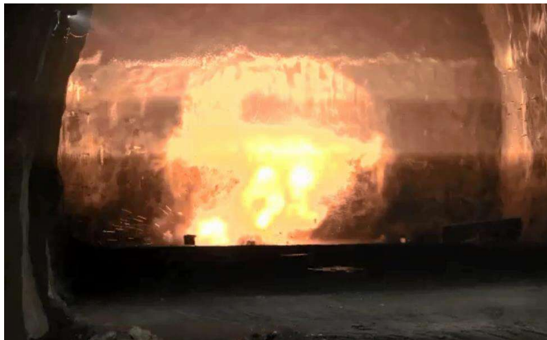
Fig. 4.4 Esplosione per scavo
