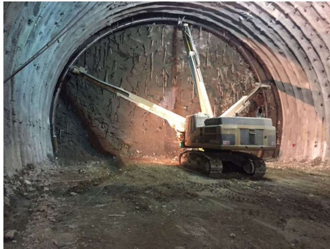
Fig. 4.9 Posizionamento e regolazione delle centine tramite bracci telescopici
