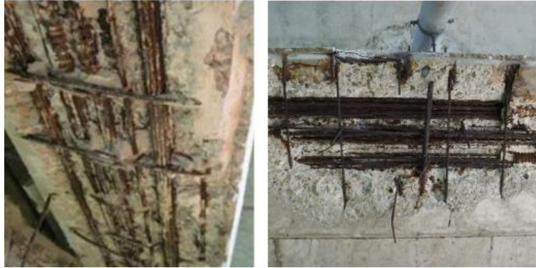
Figura 2.2: guaine degradate e fili ossidati (ricavata da [4])
