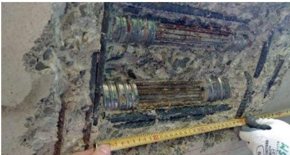
Figura 2.12: zona „scoperchiata“ per poter indagare il cavo, e gli elementi da precompressione, tramite la prova del Saggio diretto (presa da [4]).
