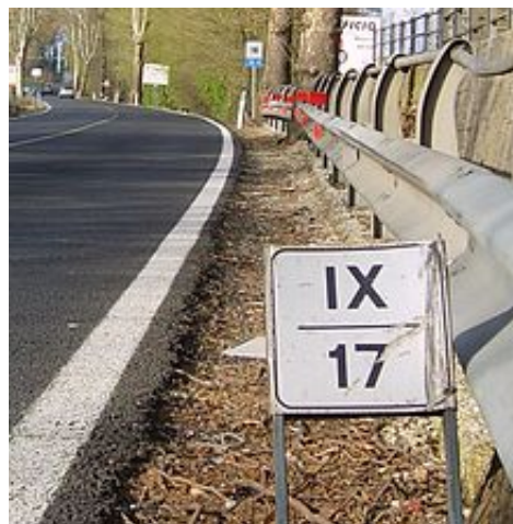
Figura 2.3: Segnale di progressiva chilometrica
