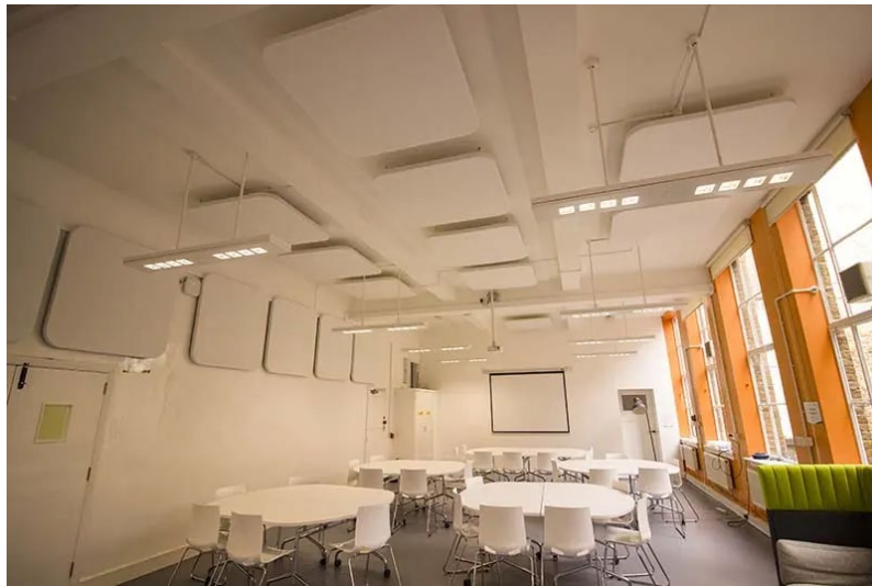
Figura 2.7. Pannelli vibranti per assorbimento acustico [7].
