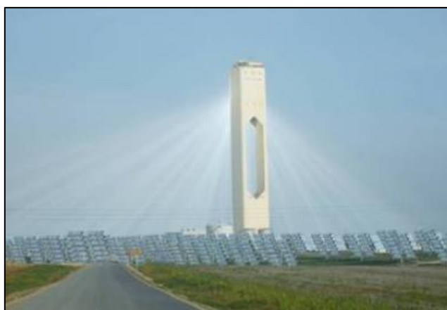
Figura 2.10 - Impianto a torre centrale PS10 [7]
