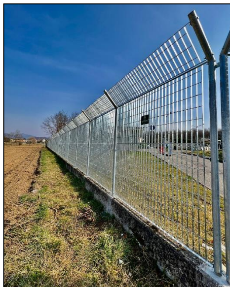
Figura 3.8 - Barriere attorno ad una regione di eliostati [20]
