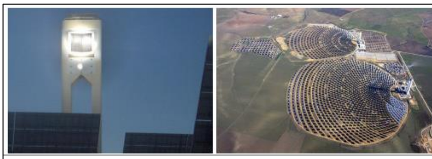
Figura 3.13 - Abengoa PS-10 e PS-20 [21]
