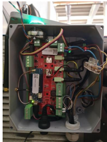
Figura 89 - Scheda T&F installata su una saldatrice
