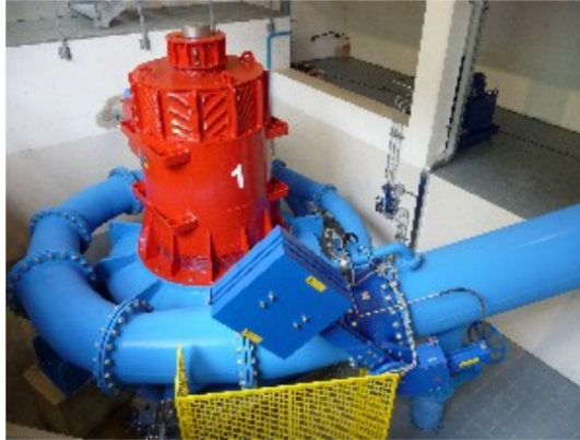
Figura 6.7: Turbina Pelton a getti ed asse verticale [32]
