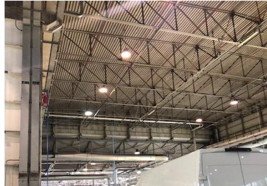
Figura 65: lampade a ioduri metallici in area Collaudo e Finizione
