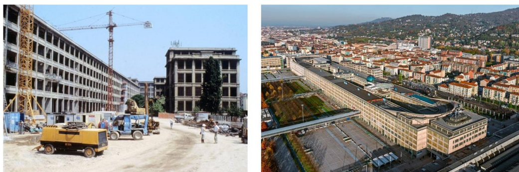
Figura 16 - La ricostruzione dello stabilimento e l'obiettivo raggiunto tramite tale processo [25][26]
