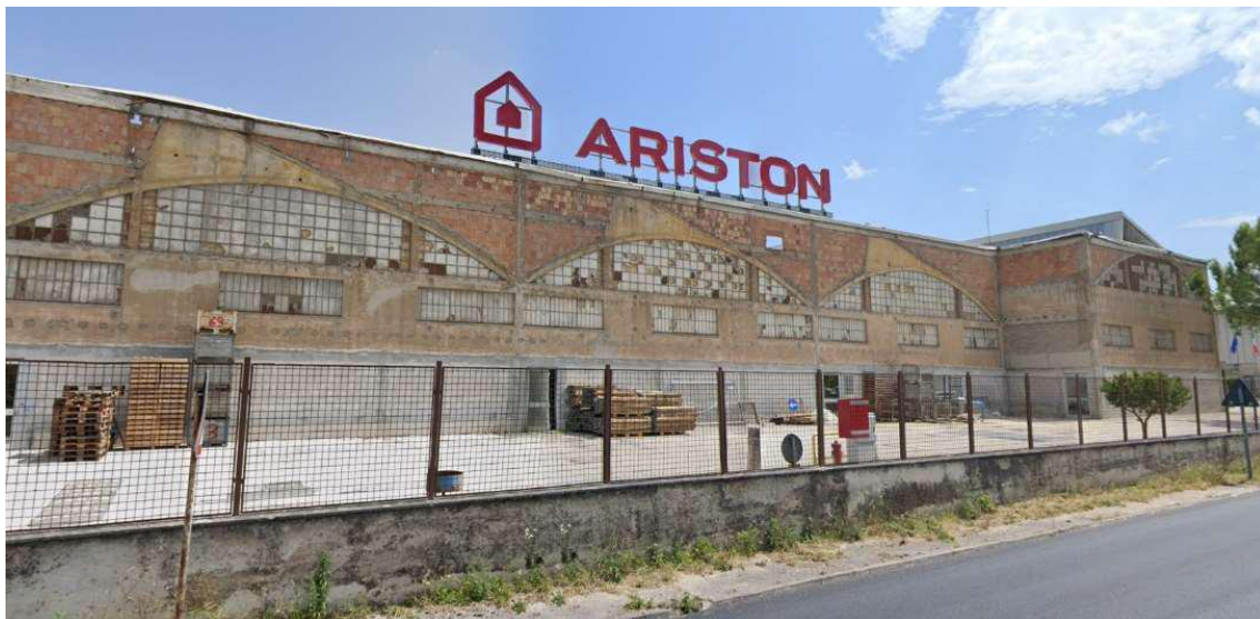
Figura 1.6: Vista frontale Stabilimento di Albacina (AN)
