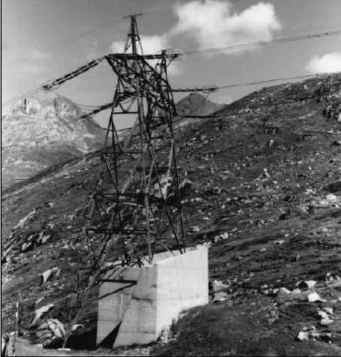
Figura 15: Foto cuneo in calcestruzzo a protezione di un traliccio (McClung & Schaerer, 1996).
