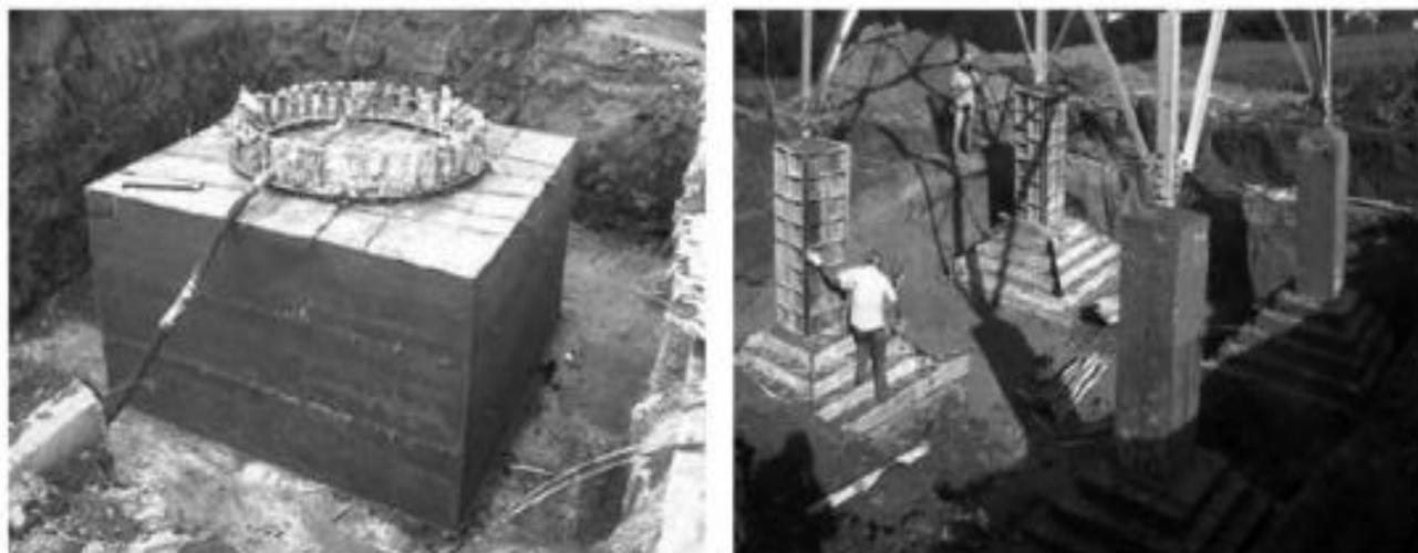
Figura 34: Esempio di fondazioni per una linea elettrica aerea AAT (Benato & Fellin, 2011).
