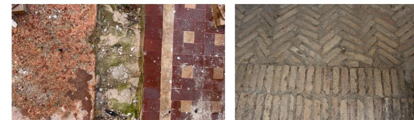
Fig. 63 Pavimentazione al piano terra della barchessa, con piastrelle e sottofondo in mattoni
