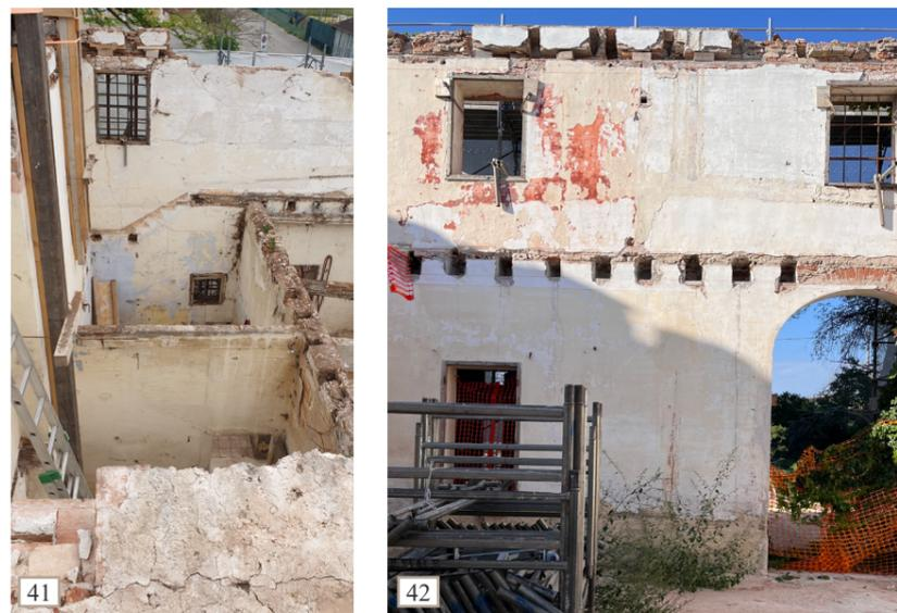
Da Fig. 41 a Fig. 54 Viste interne della barchessa a nord, con inquadrature di dettaglio delle parti distrutte, delle sedi originali delle travi, della ricostruzione della muratura sommitale con il cuci-scuci e delle uniche travi del solaio che si sono conservate integre
