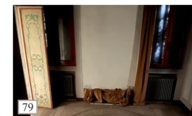
Fig. 79 Dettaglio delle nicchie sotto le finestre dove sono stati collocati i termosifoni
