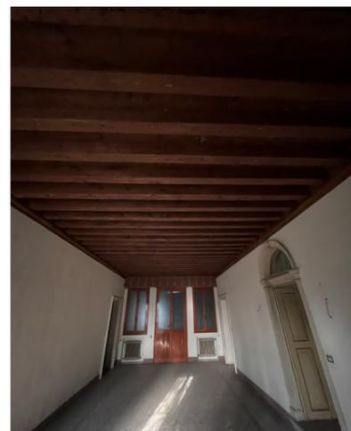
Fig. 69 Salone centrale al piano terra con vista della travatura lasciata a vista, lato nord
