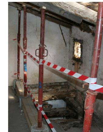
Fig. 65 Dettaglio del solaio mancante dell'annesso a nord, visto dal primo piano
