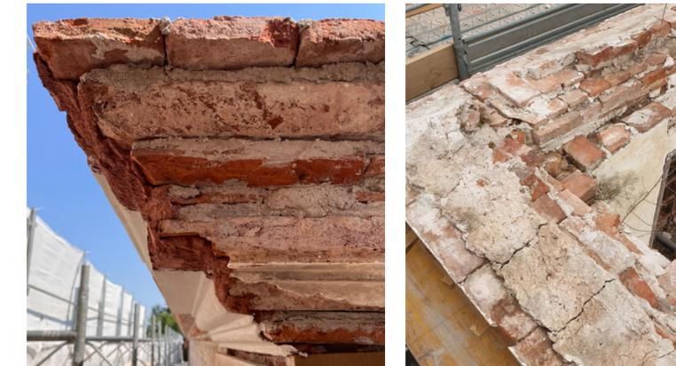
Fig. 55 Prospetto nord angolare della cornice della barchessa, dove si può vedere la stratigrafia che compone il blocco decorativo
