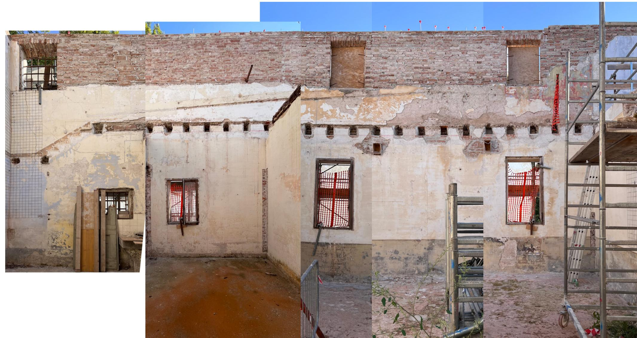
Fig. 136 Strisciata fotografica, dettaglio della ricostruzione della muratura a est con il sistema cuci- scuci
