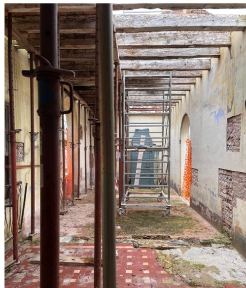
Fig. 138 Vista delle travi conservate nella stanza a sud-ovest
