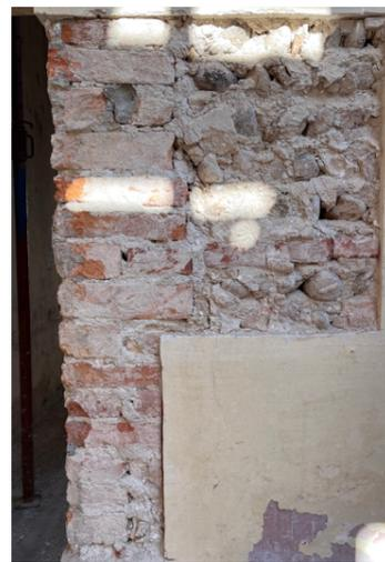
Fig. 132 Tessitura muraria della parete perimetrale, in sassi e corsi di mattoni
