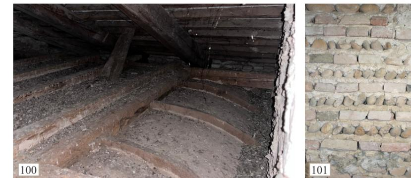
Fig. 98 Dettaglio del controsoffitto appeso delle stanze angolari
