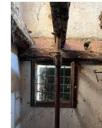
Fig. 66 Dettaglio del solaio mancante dell'annesso a nord, visto dal piano terra
