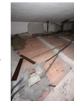
5 Solaio tipo Varese, è composto da travetti prefabbricati in calcestruzzo armato intervallati da tavelloni in laterizio. Questo genere di orizzontamento si è diffuso a partire dagli anni '40 del Novecento ed era stato concepito per sostituire il solaio in legno.
