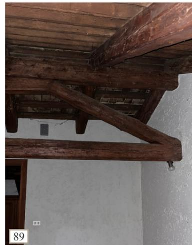
Fig. 86 Dettaglio nodo trave di colmo e puntoni angolari, ortofoto dal basso
