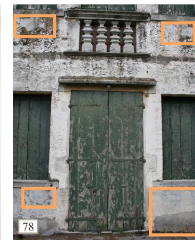
Fig. 78 Dettaglio del prospetto nord del corpo nobile, dove sono evidenziati gli strati incoerenti degli interventi più recenti con malta cementizia
