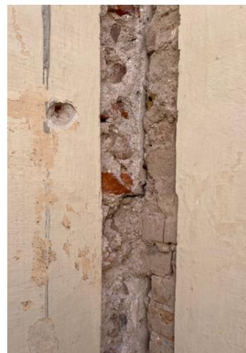
Fig. 134 - 135 Saggio sulla muratura e il tramezzo, che evidenzia il mancato ammassamento tra gli elementi
