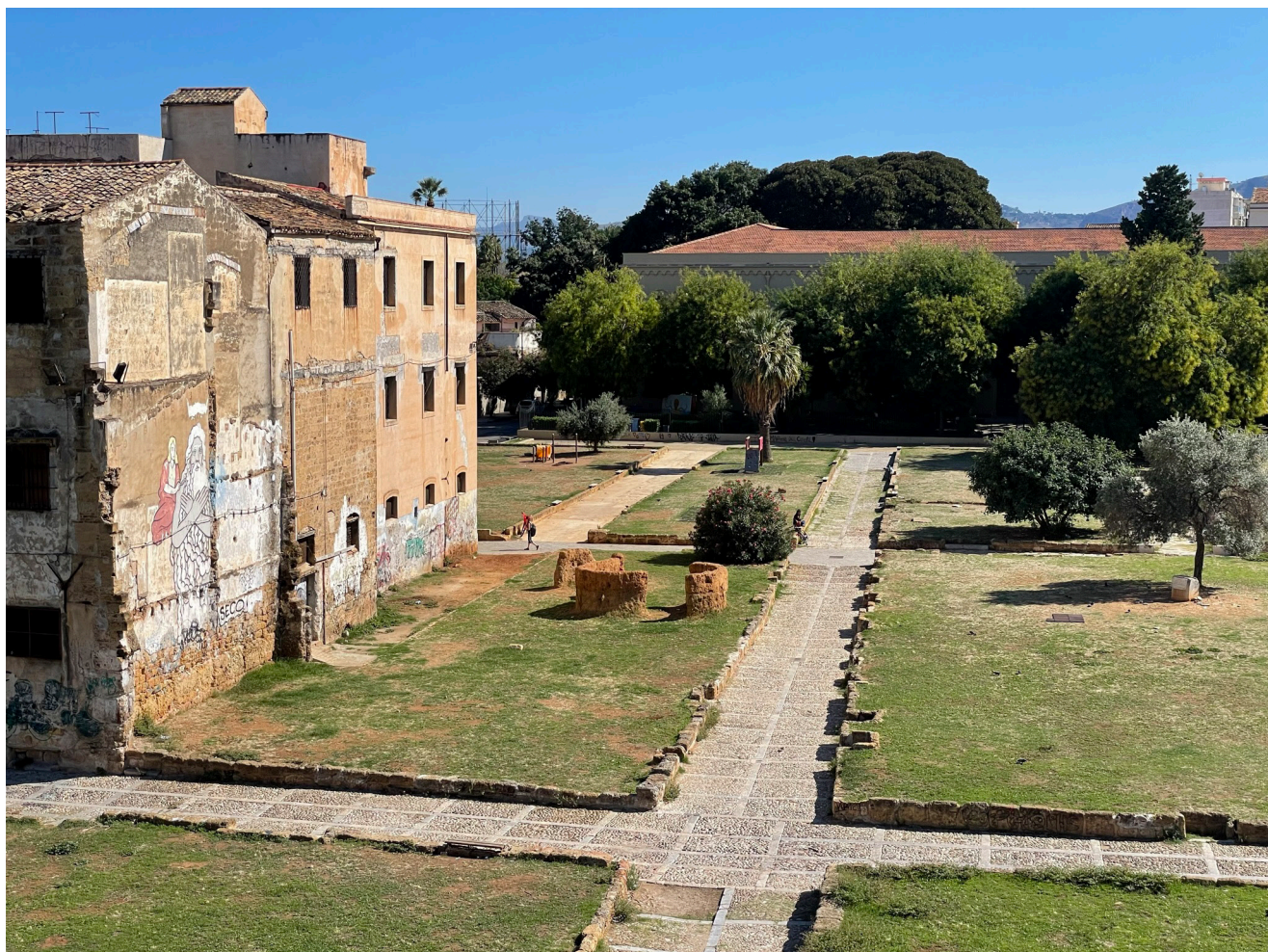
8 | Vista da uno dei fabbricati prospiciente il giardino
