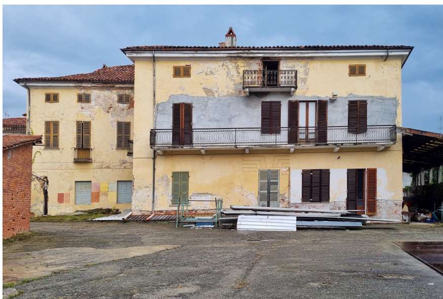
Figura 25: facciata sud di Palazzo Mautino, fotografia scattata dal cortile interno. 2023.
