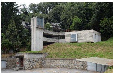
Figura 14: Edificio ex Sertec. Fonte: https://www.ivreacittaindustriale.it/i-beni/edificio-ex-sertec/
