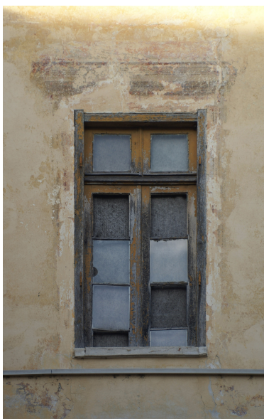
Figura 24: Decorazione pittorica murale che incornicia un'apertura di Palazzo Mautino. Fotografia di M. Zerbinatti 2023.
