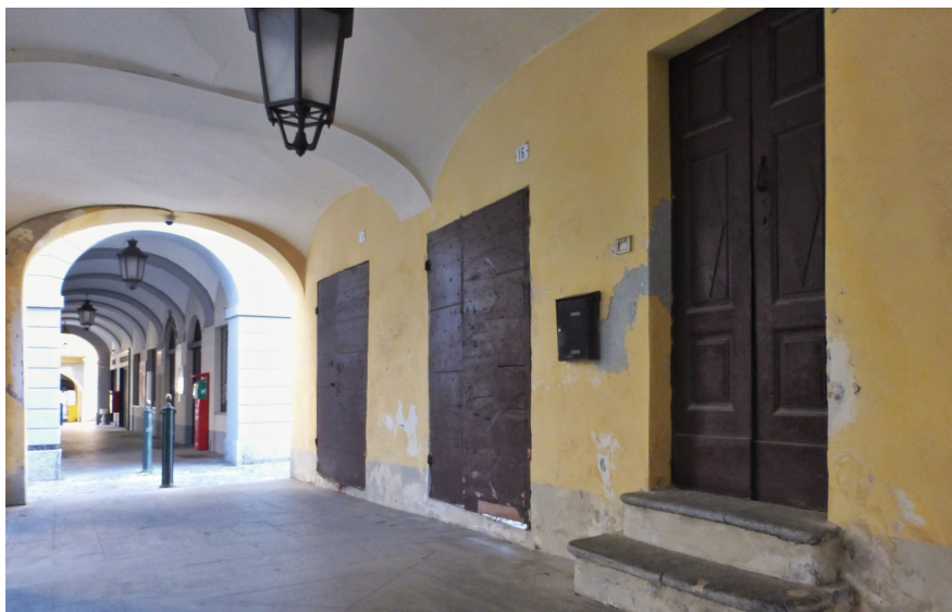
Figura 29: Edificio residenziale in via Principe Tommaso. Fotografia di M. Zerbinatti. 2023
