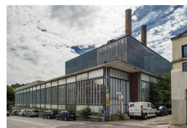
Figura 10: Centrale Termica. Fonte: https://www.ivreacittaindustriale.it/i-beni/centrale-termica/
