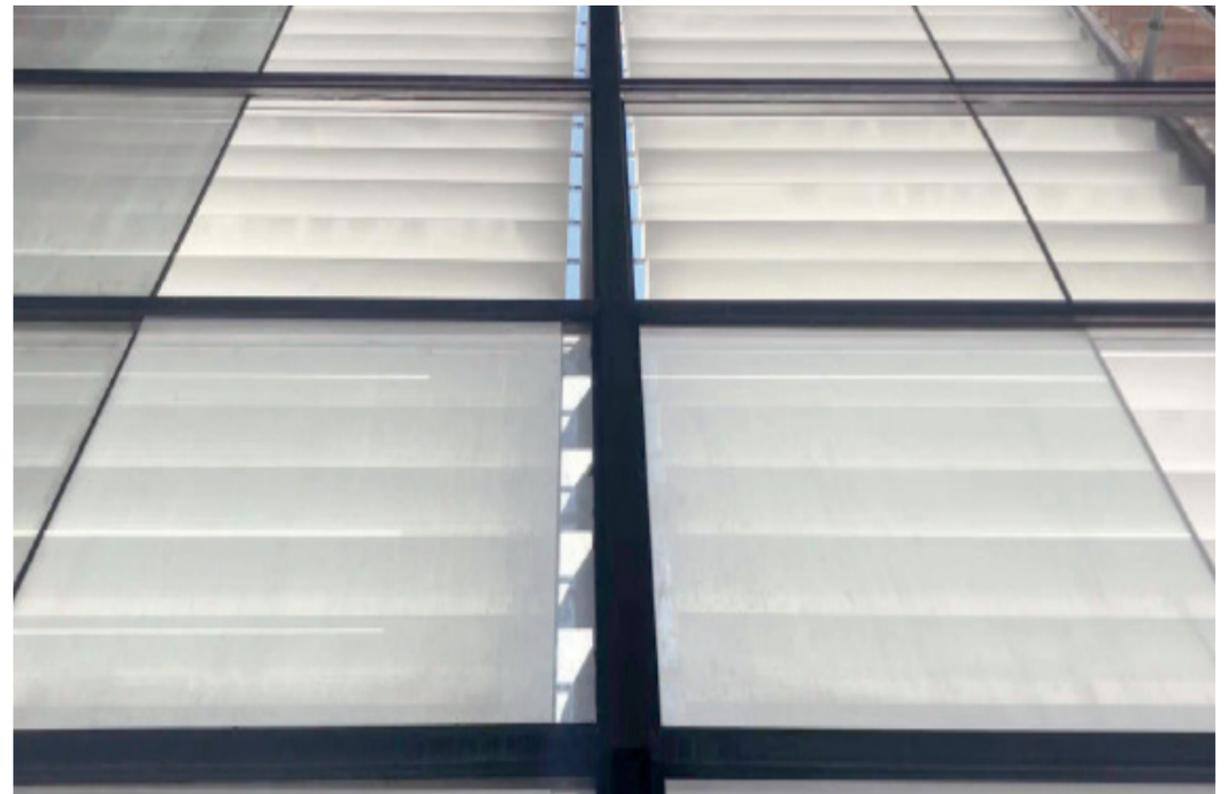
FIG 2: Schermature solari esterne restaurate e verniciate di bianco come in origine. Sopralluogo, 16 Marzo 2023, Fotografia di LP
