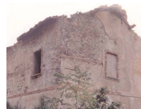
119_Foto satellitare stazione di Pastorella 120_Foto stazione di Pastorella
