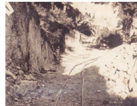
93-97_Lavori per la realizzazione della tratta Lagonegro-Castrovillari
