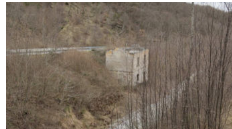
132_Foto satellitare casa cantoniera 133_Vista casa cantoniera
