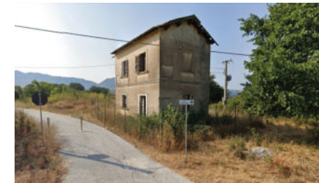
146_Foto satellitare casa cantoniera Fiumara
