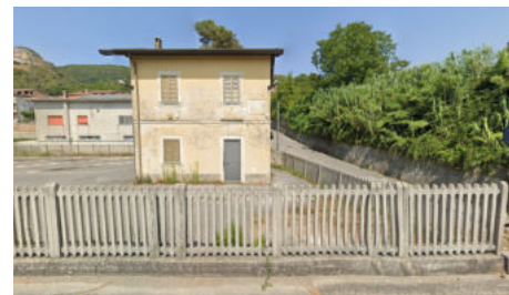
143_Foto satellitare stazione e casa cantoniera Castelluccio Inferiore
