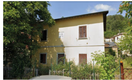
112_Foto satellitare casa cantoniera di bivio Latronico 113_Vista casa cantoniera di bivio Latronico
