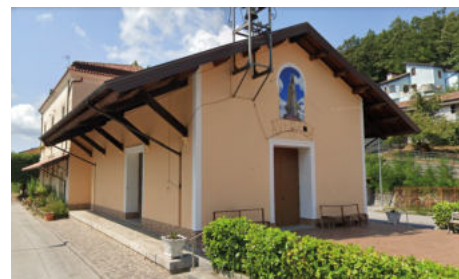
114_Foto satellitare stazione di bivio Latronico 115-116_Viste stazione di bivio Latronico
