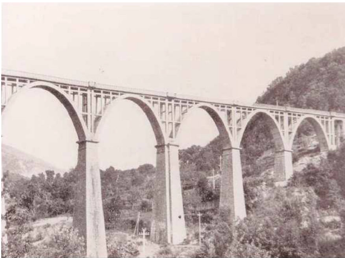
92_Il viadotto sul fiume Serra presso Lagonegro "Ponte degli Studenti" in una foto d'epoca
