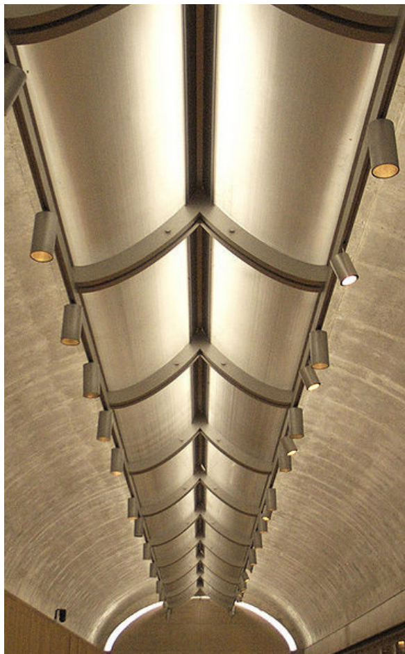
a sinistra: dettaglio del sistema di illuminazione naturale tramite riflettori e artificiale per mezzo di spotlight
