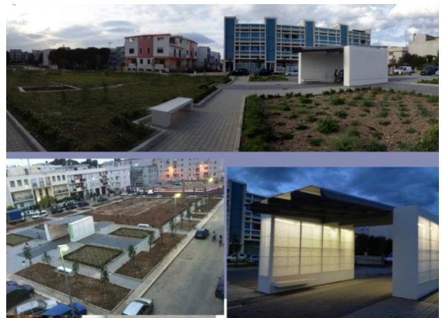
Figura 4 – Interventi realizzati mediante PIRP Rutigliano (BA). Fonte: Rigenerazione urbana e territoriale in Puglia: dalle strategie alle azioni. Pratiche di rigenerazione a cura di Francesca Pace, 2013.
