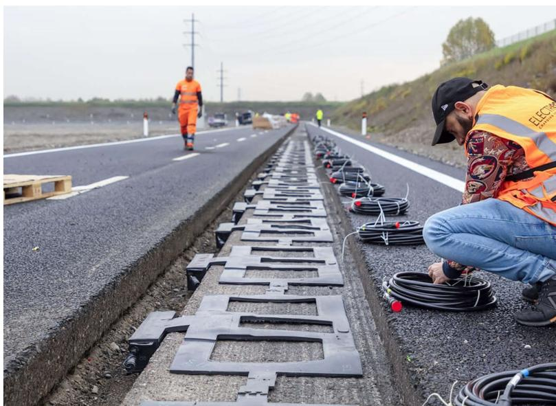
Figura 2.9. Spire inserite all'interno dell'asfalto per la ricarica dei veicoli elettrici in transito
