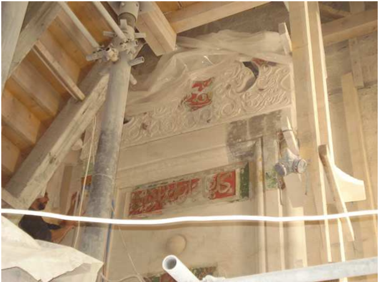
Anastilosi e ricostruzione delle parti mancanti del mihrab nella moschea "Ferhadija" a Banja Luka
