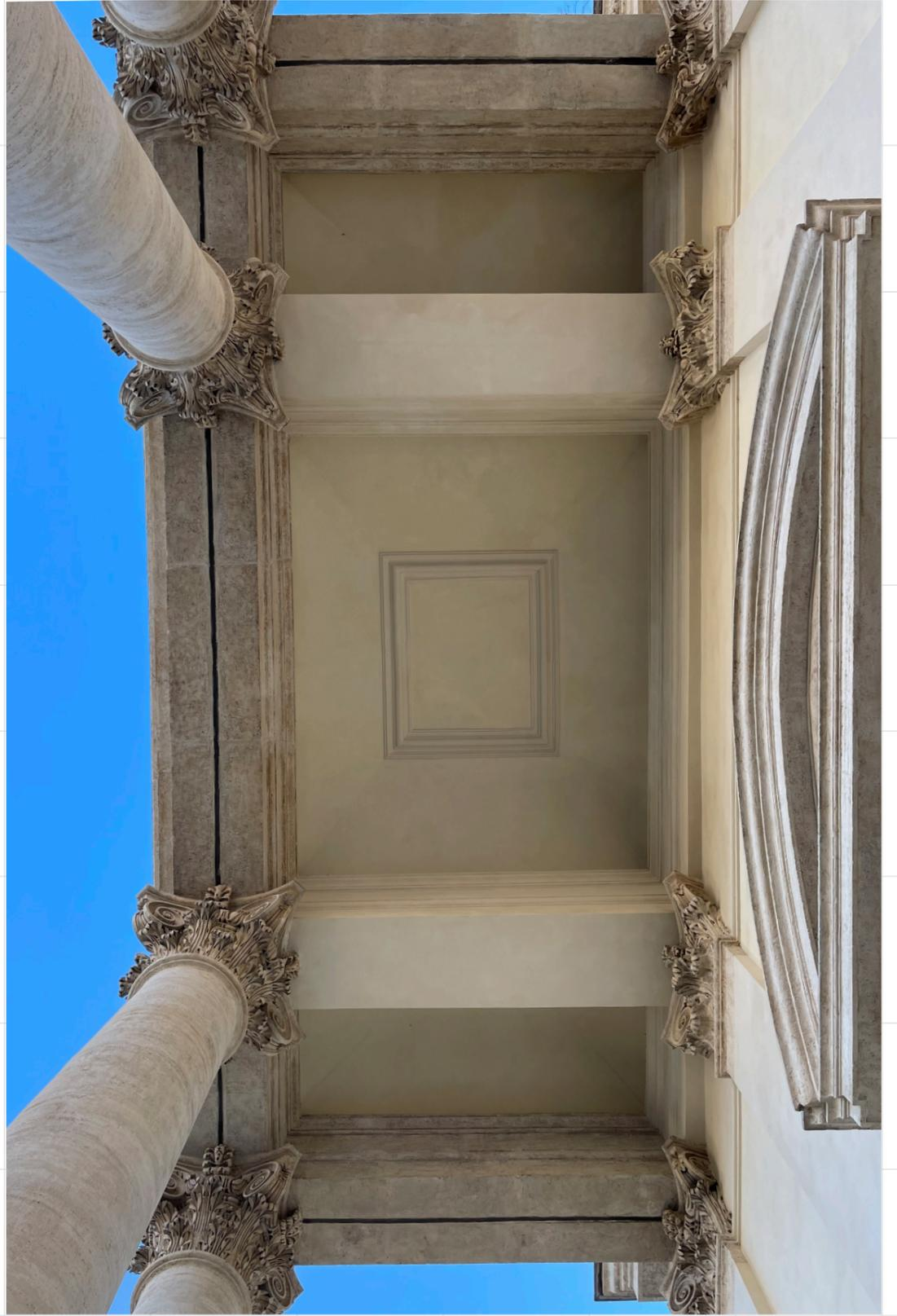
**D**a un punto di vista formale i due pronai delle chiese gemelle risultano più piccoli e schiacciati rispetto al pronao di Superga, la fila di colonne è unica, le volte a padiglione sono tre e di dimensioni ridotte rispetto all'unica grande volta a padiglione del pronao di Superga.
