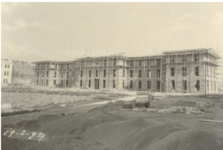
Fig. 47 Albenga. Caserma Piave in costruzione. 1929
