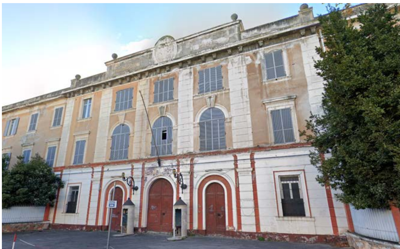
Fig. 58 – Facciata Nord-Est, ingresso principale, Ex Caserma Piave, Albenga
