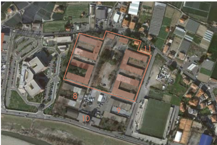
Fig. 43 Albenga. Ex caserma Aldo Turinetto. Delimitazione area di cantiere e edifici interessati alle demolizioni. Relazione generale redatta dall'Ing. F. Briano. 2020
