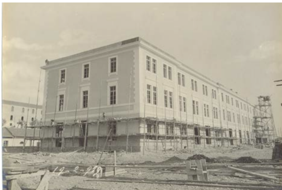
Fig. 46 Albenga. Caserma Piave in costruzione. 1929
