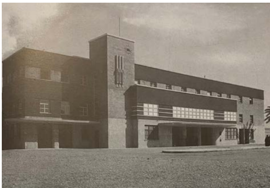
Fig. 5 Arch. Narducci, Stazione ferroviaria di Albenga, 1937
