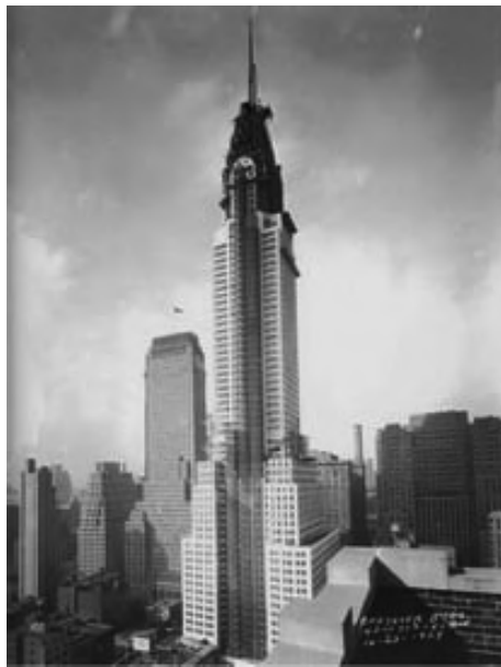
Figura 1.2. Il Chrysler Building di New York in costruzione, 1929
