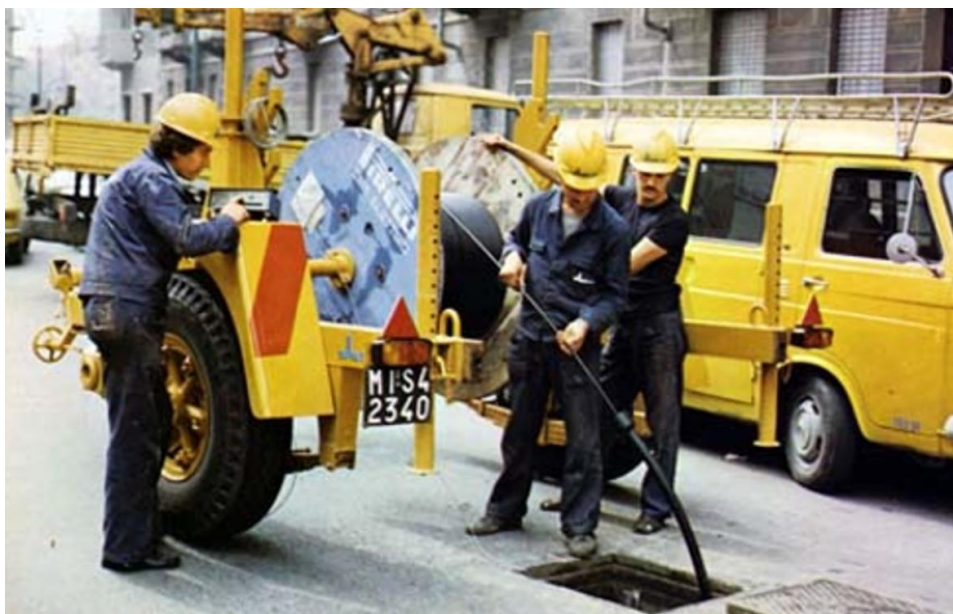
Figura 1.1 L'immagine ritrae tre operai durante le operazioni di posa del primo cavo in fibra ottica a Torino. (Estratta da: https://www.serviziarete.it/ )
