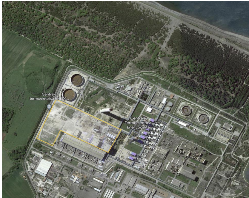
Figura 35 - Area disponibile per installazione pannelli fotovoltaici, esposizione Sud
