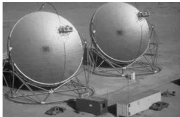
Figura 3.18 – I due concentratori parabolici costruiti a Riyadh [53]
