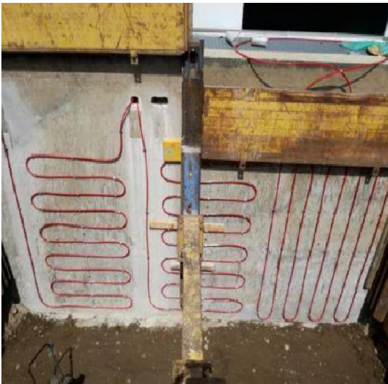
Figura 24 Fase di posa sonde geotermiche (sx) e dettagli su misura e disposizione sonde (dx)
