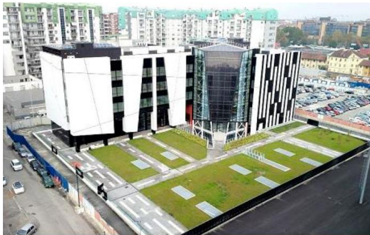
Figura 20 Visura energy center
