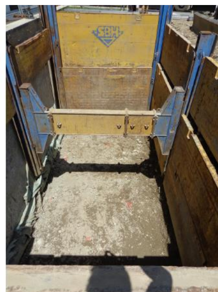
Figura 23 Fasi di scavo ed edificazione rinforzo (sx) e stesura di strato di calcestruzzo orizzontale durante lavori in Energy center
