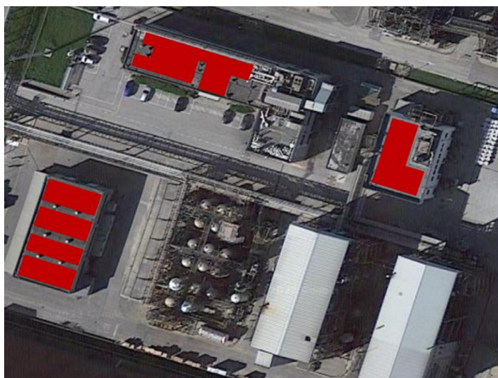
Figura 92 Superficie coperta dello stabilimento utile all'installazione di pannelli FV
