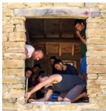
Lavori a Cascina Crocetta, Castelletto Uzzone, 2019
