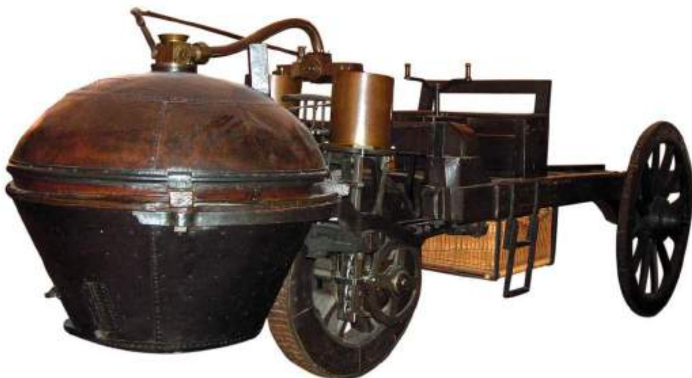
Figura 1: Il Carro di Cugnot, nella versione del 1771, conservato al Musée des arts et métiers di Parigi.
