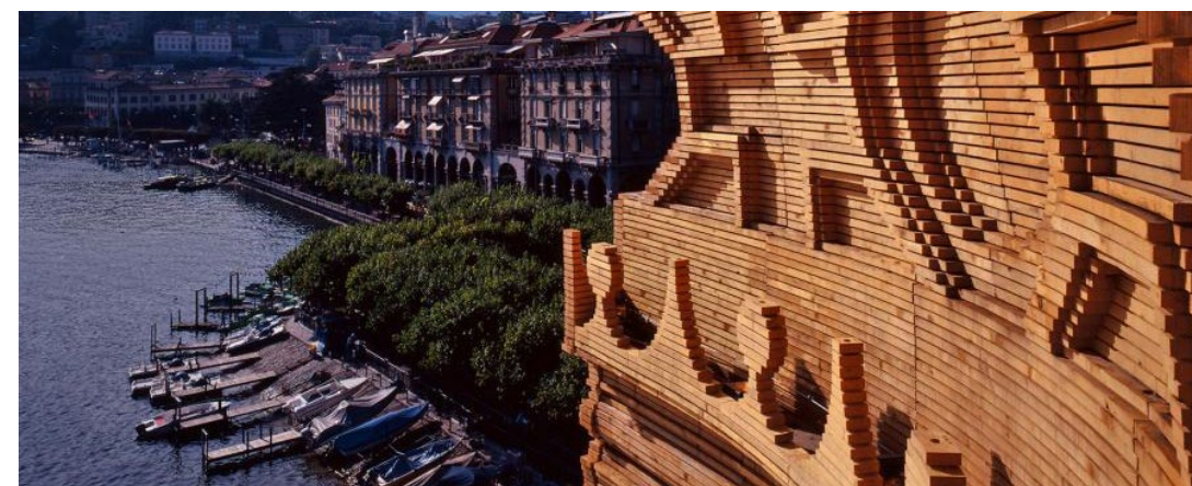
Particolare del San Carlino, M. Botta - Lugano (Svizzera 1999).
