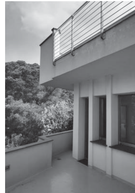
Scansioni della sezione, del prospetto laterale e pianta di copertura, in scala 1:50 (pagina a fianco).
