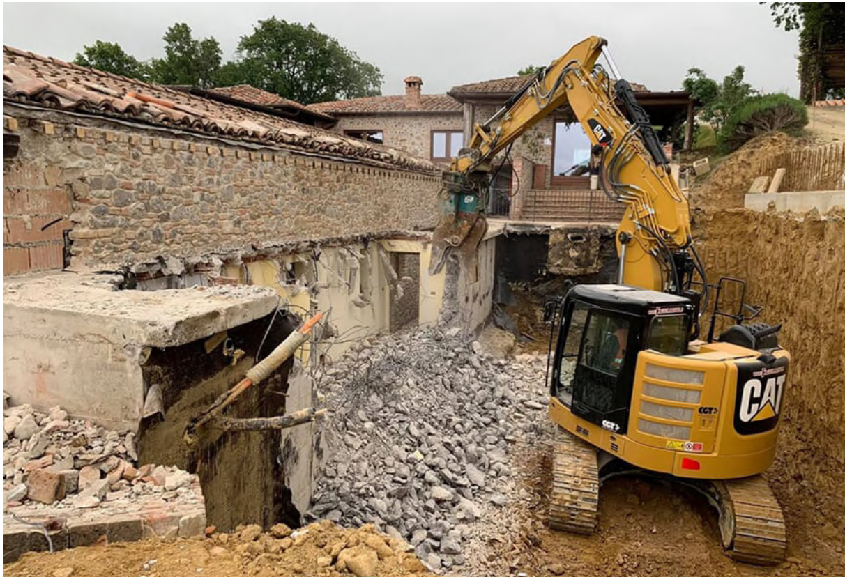
Figura 2.8. Demolizione edificio in muratura con pinza demolitrice.
