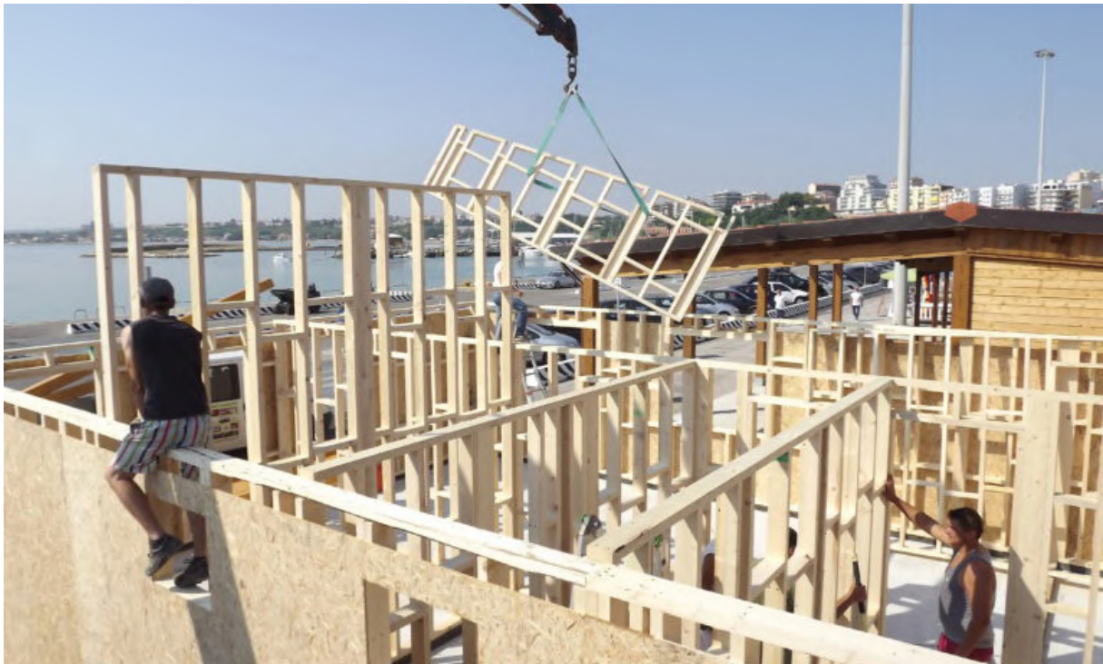
Figura 2.19._ Sistema costruttivo a telaio.
