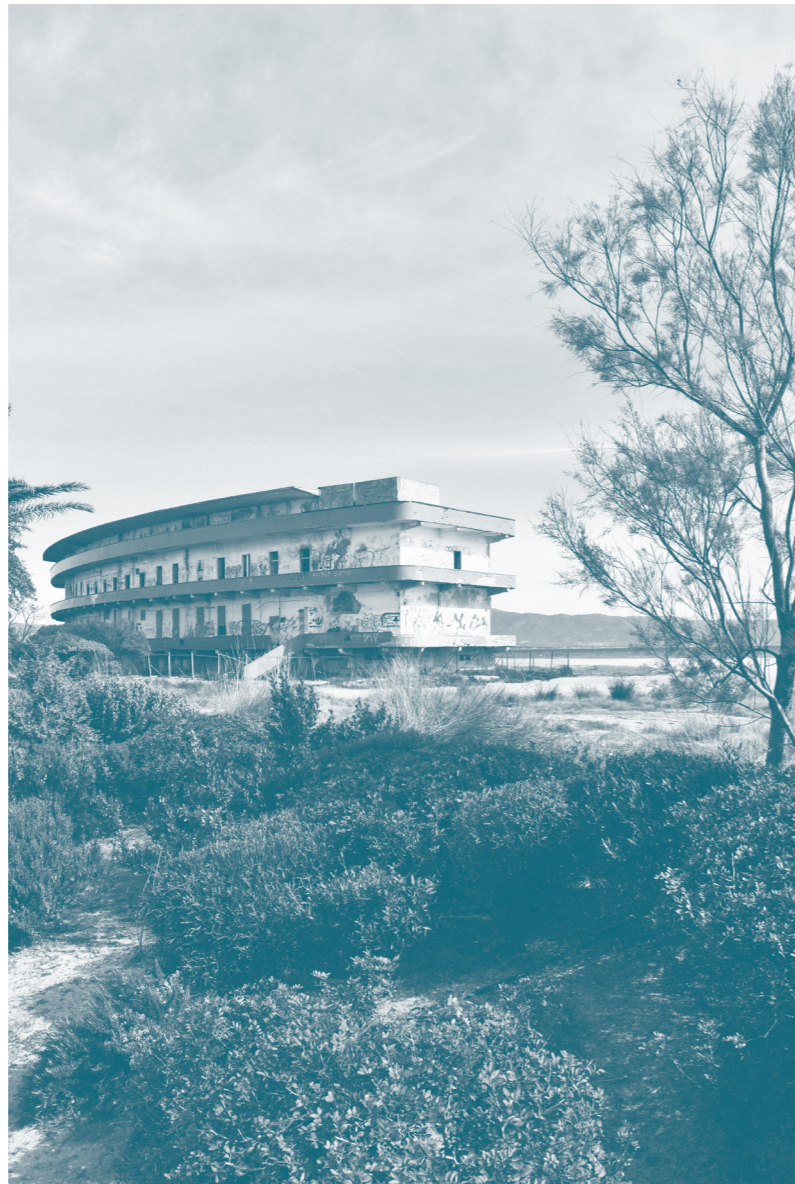
Fig. 8.1: Vecchio Ospedale Marino visto dal Lungomare (© Gaia Siddu, 2022)
