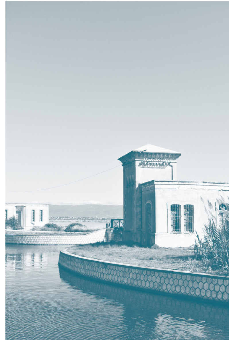
Fig. 5.2: Idrovora del Rollone (© Gaia Siddu, 2022)
