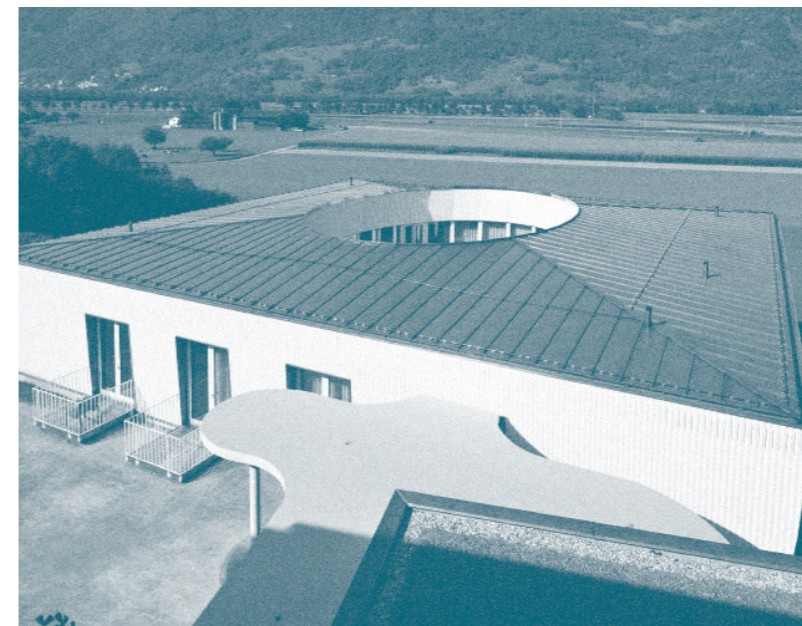
Fig. 3.13: Spazio comune in affaccio alla corte interna (© Vincenzo Cangemi Architekten)
