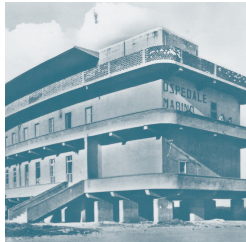
Fig. 6.27: Rustico della Colonia Marina Dux (© Archivio Storico di Cagliari)
