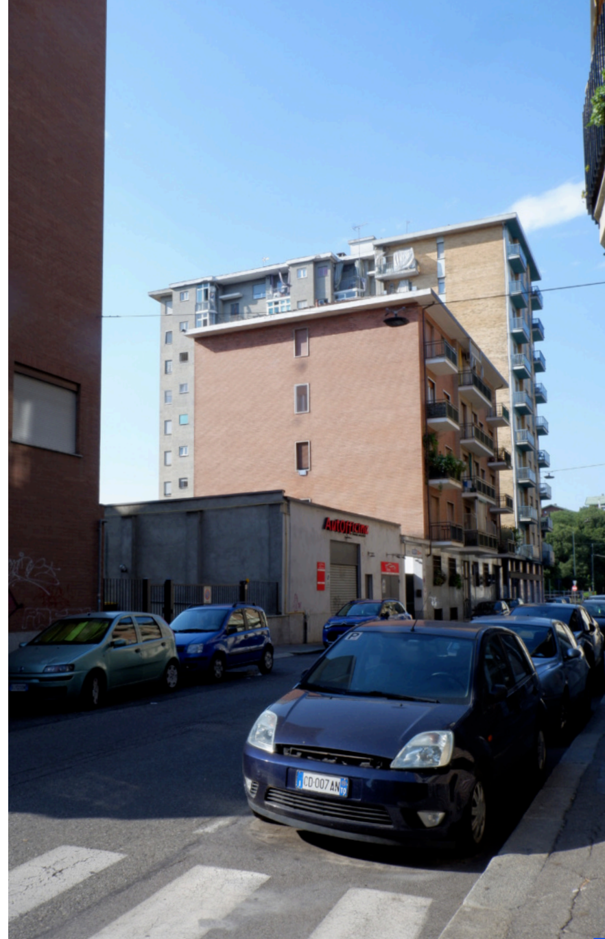
Foto su Via Bari lato est
