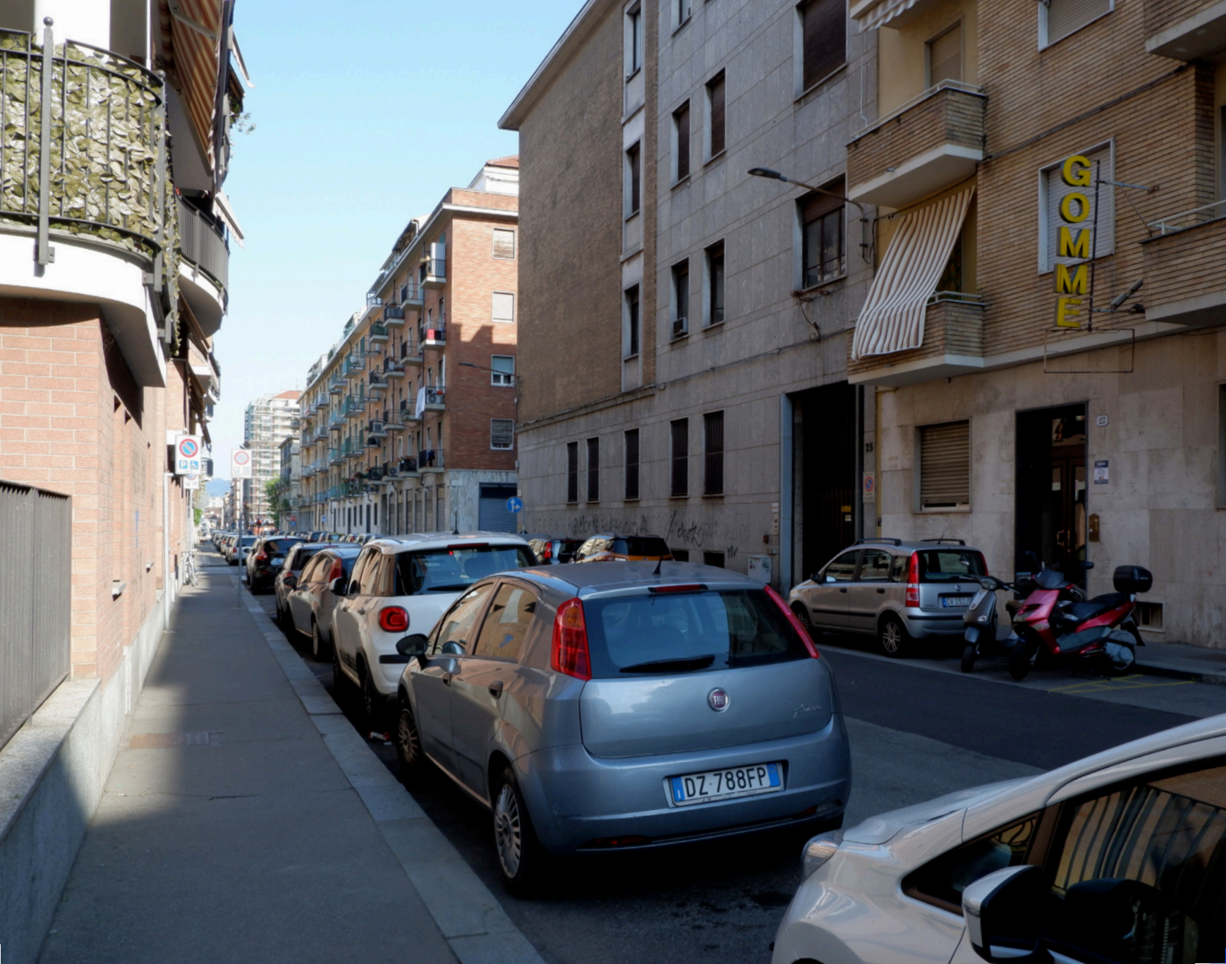
Foto su Via Don Bosco lato nord A
