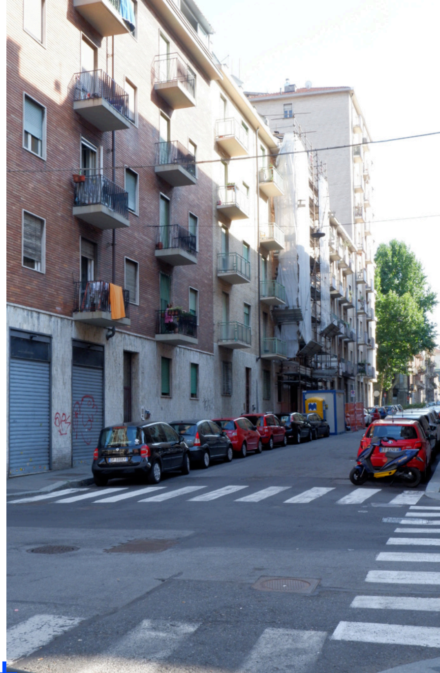
Foto su Via Bari lato ovest
