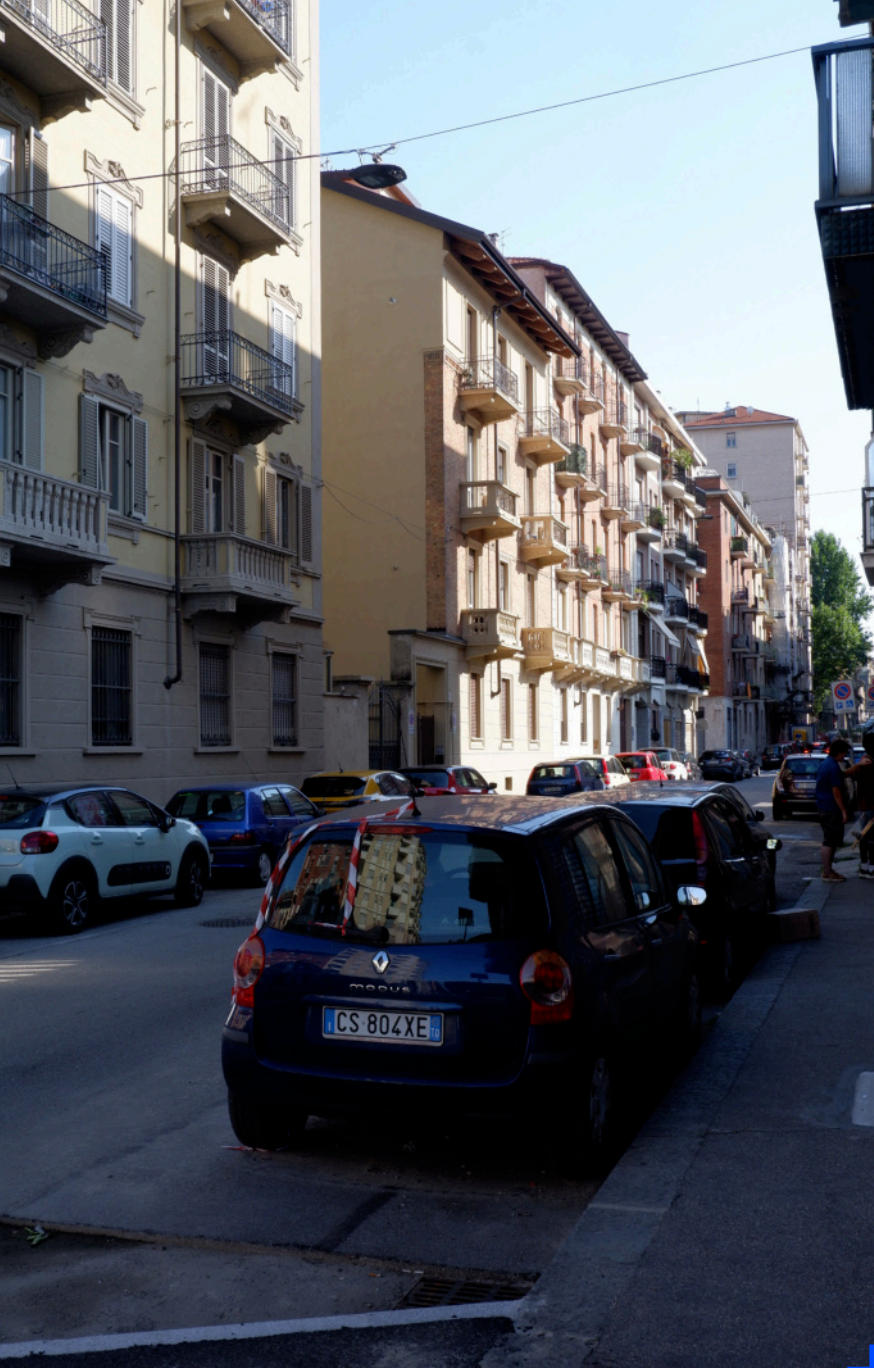
Foto su Via Bari lato ovest
