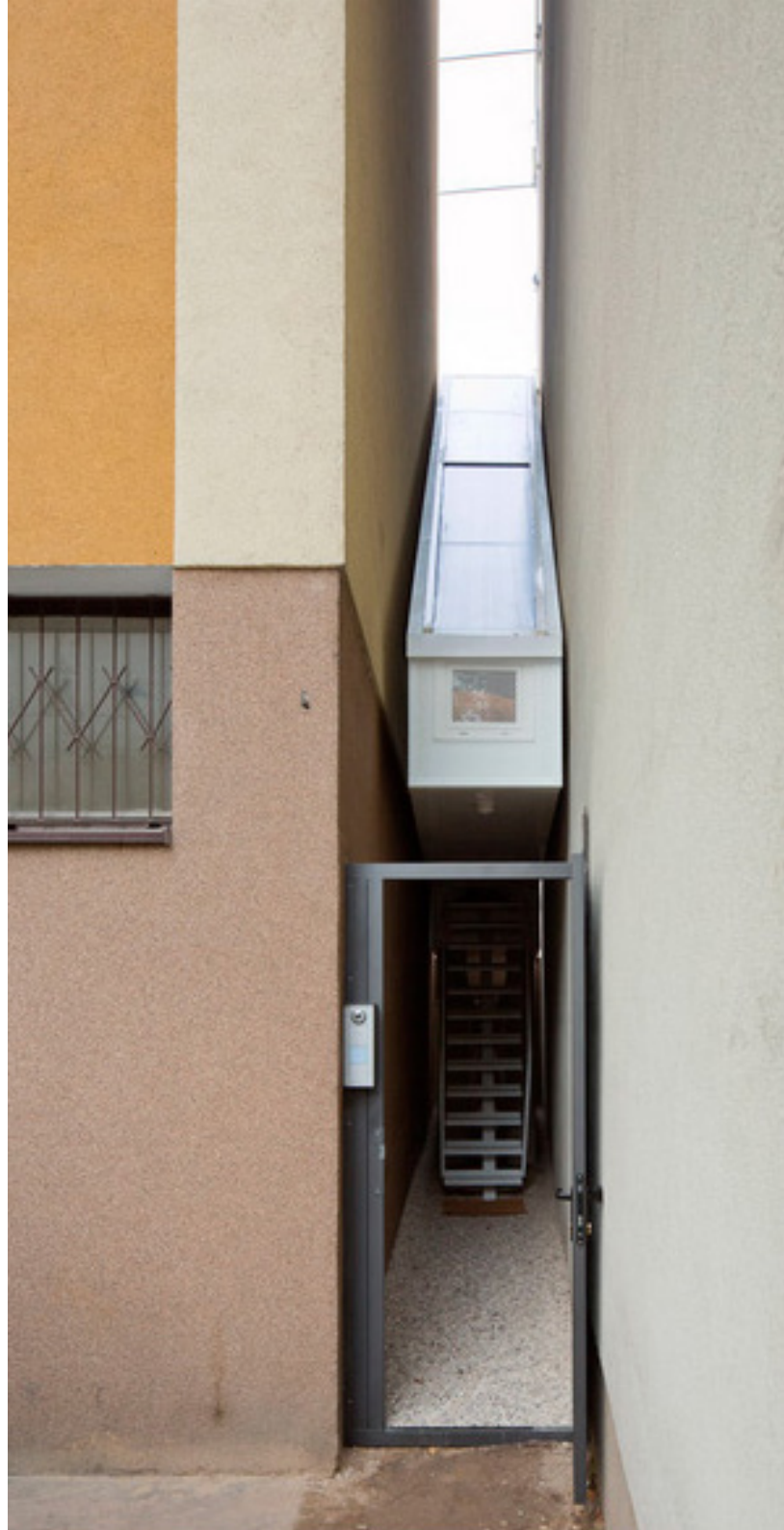
fig. 70 Ingresso, Keret House, Varsavia
