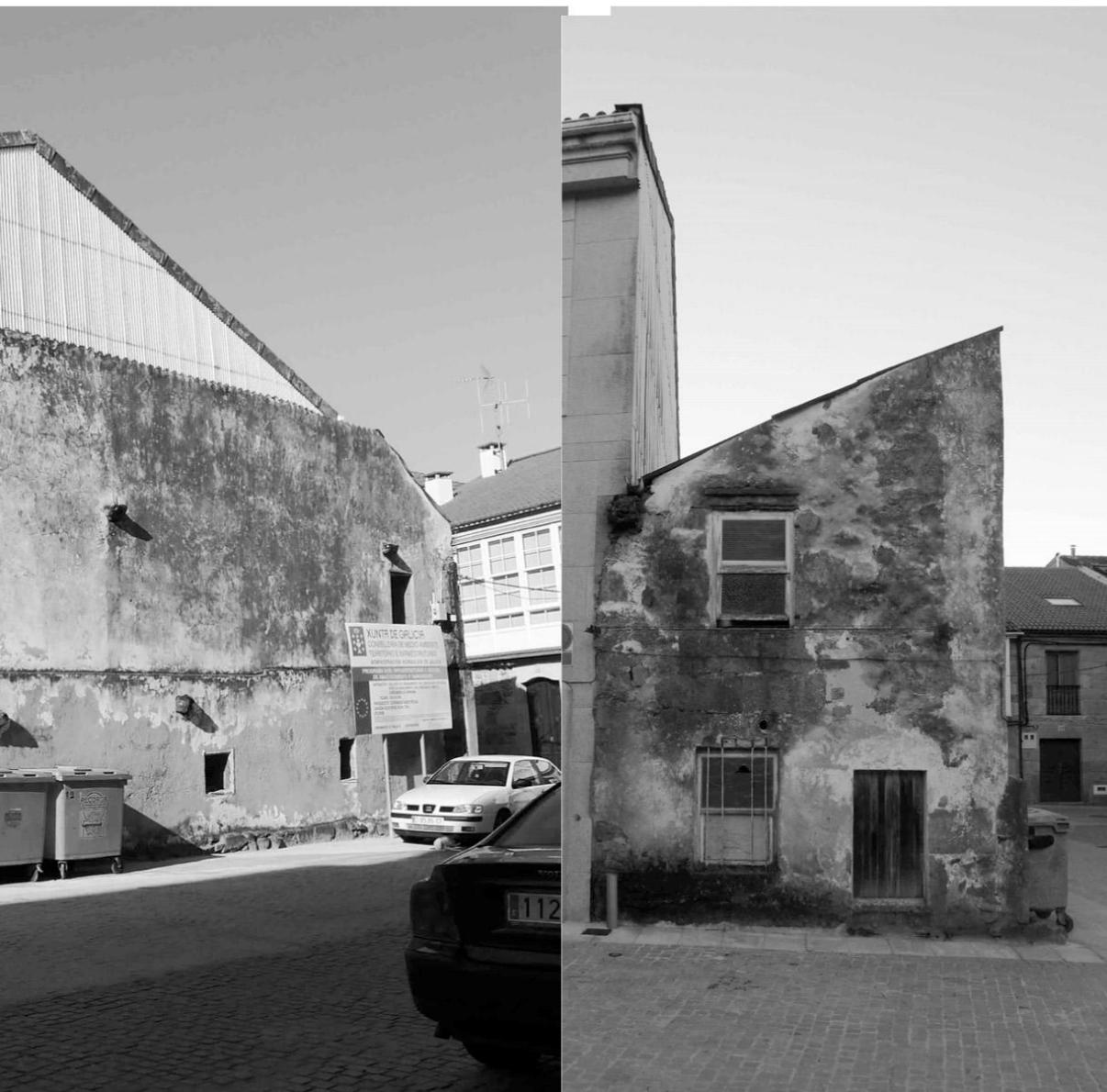
fig. 30 Creus y Carrasco Arquitectos, Chao House, Corcubiòn, 2013. Abitazione prima del progetto, in stato di rovina.
