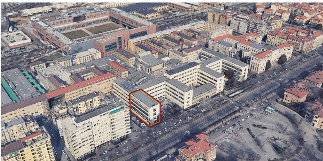
Fig 2.15 Main campus of Politecnico di Torino
