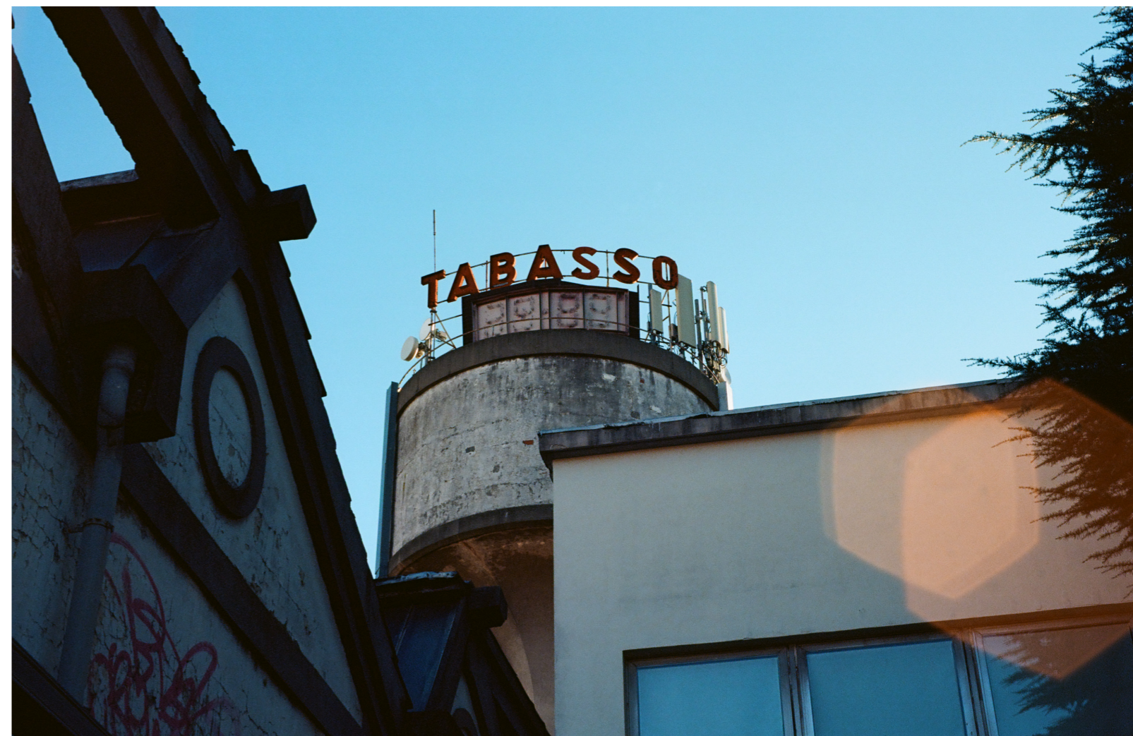
Area Tabasso, nodo torre pieziometrica/capannoni, gennaio 2023
