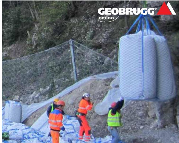
Figura 3.10: Sistema assorbente ROCKFALL-X™ G (www.geobrug.com).
