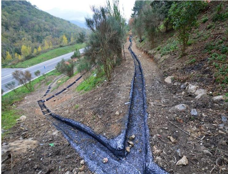
*Figura 2.10: Foto raffigurante delle canalette per la raccolta dell'acqua di ruscellamento (www.geoprodotti.eu).*
