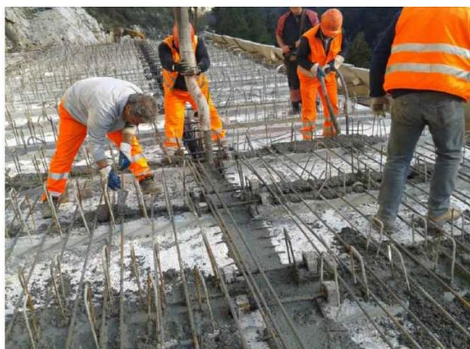
*Figura 3.13: Fase di completamento del getto della soletta (www.trasparenza.provincia.salerno.it).*
