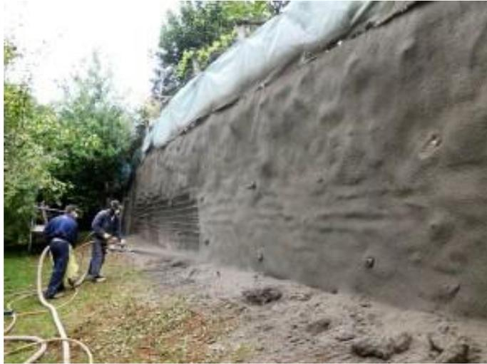
*Figura 2.8: Rappresentazione dell'applicazione dello spritz beton (www.piccole-dolomiti.it).*
