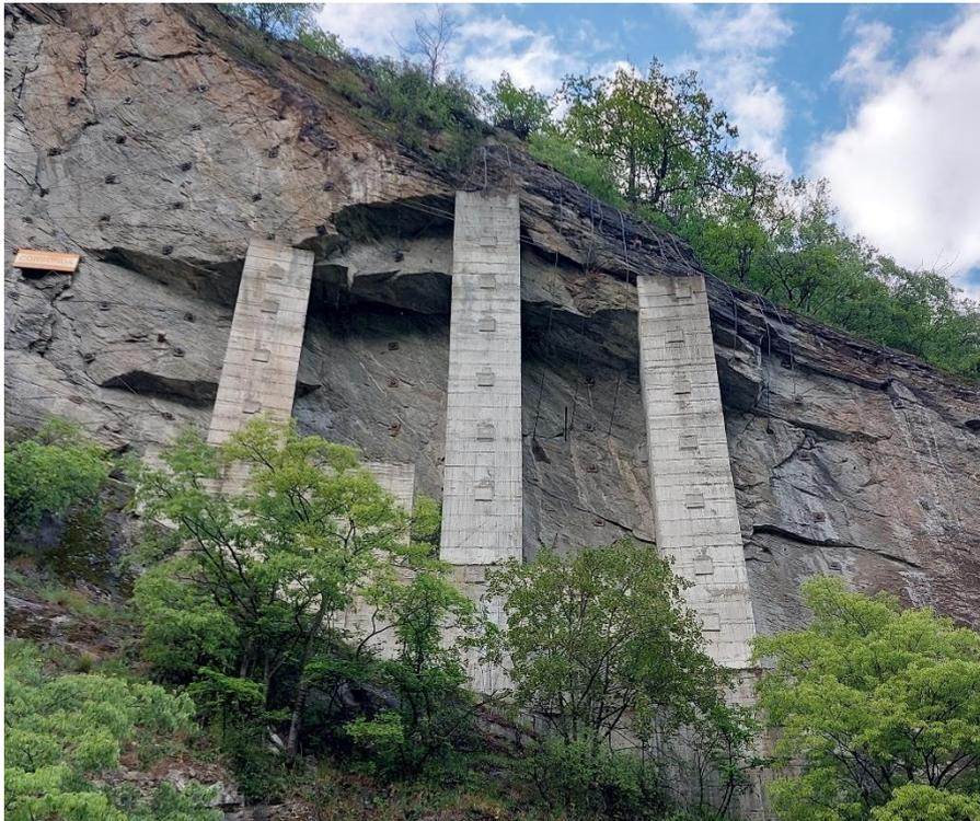
*Figura 2.5: Intervento di prevenzione costituito da contrafforti in calcestruzzo e chiodatura (foto da sopralluogo effettuato in data 07/05/2023, Exilles).*
