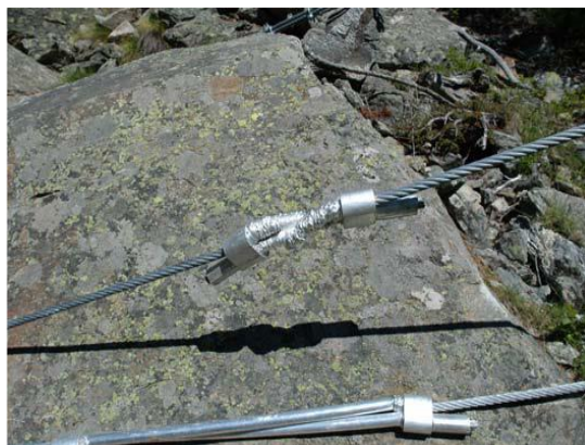
Figura 11 Esempio di dissipatori prima e dopo l'urto
