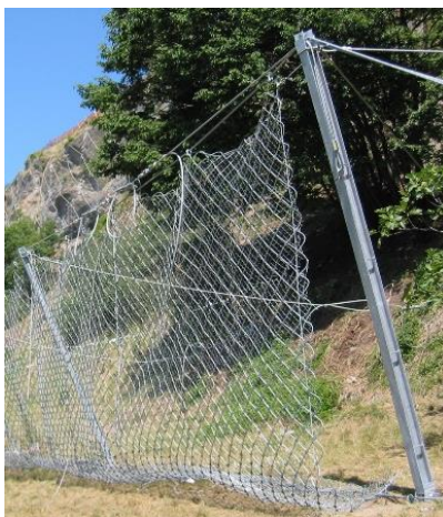
Figura 9 Rete appesa e non ancorata ai montanti
