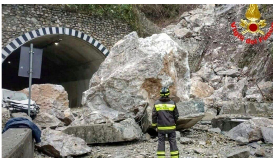
Figura 1 Grossi massi sono caduti sulla strada che collega Lecco a Ballabio: la frana ha bloccato l'ingresso di una galleria (17)
