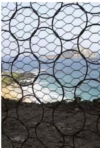
Figura 7 Rete ad anelli con rinforzo per materiale fine
