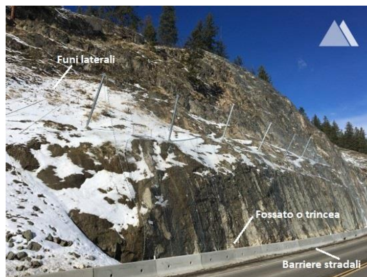
Figura 27 Installazione lungo strada con barriera stradale e trincea di accumulo, West Kelowna, BC, Canada (27)
