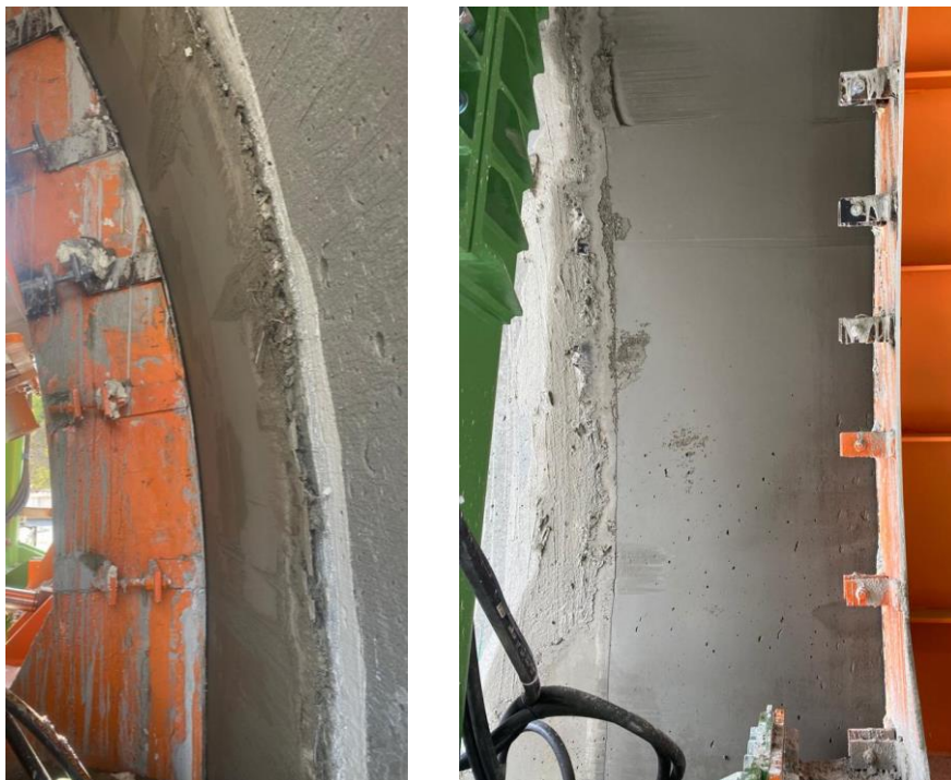
Figura 3-8: Dettaglio connessione dei conci consecutivi.
