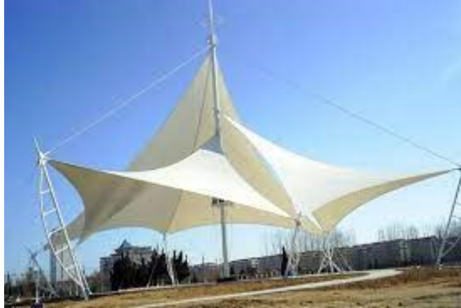
Figura 53: Esempio di membrana di fibra di poliestere spalmata PVC
