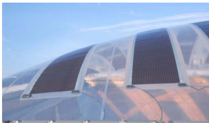
Figura 87: Pannelli fotovoltaici flessibili integrati in fogli ETFE
