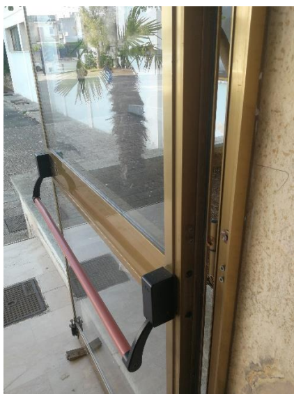
Figura 65 - foto rappresentativa infissi _ Stato di fatto
