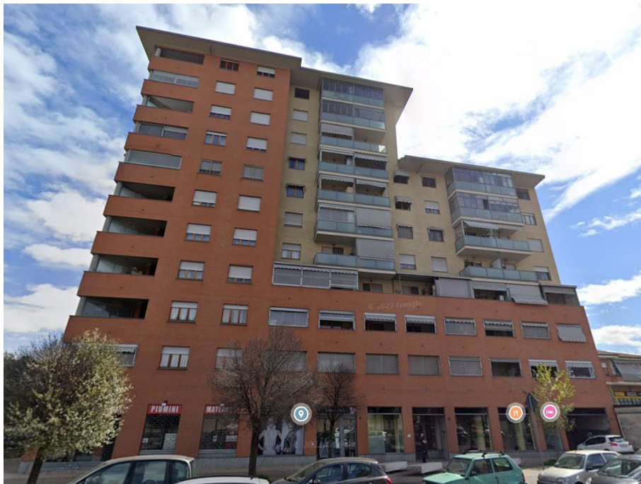
Figura 2: Scala condominiale via Ala di Stura, 60 (Google Maps)
