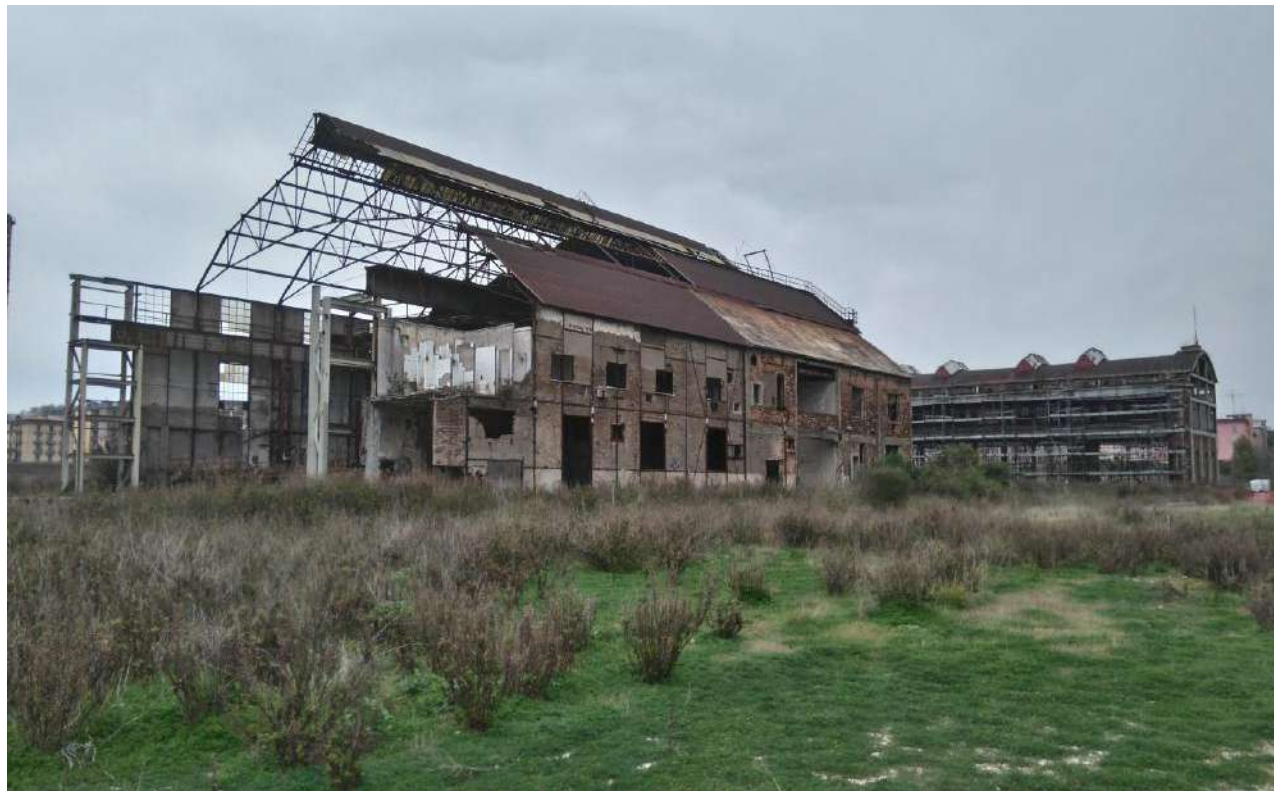
Le rovine della centrale termica nello stabilimento dell'ex Ilva (Invitalia, Programma di risanamento ambientale e rigenerazione urbana)
