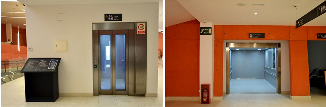
Ascensore pubblico con una capacità di 13 persone./ Ascensore montacarichi di grande capacità utilizzabile per spostare gruppi di persone in sedia a rotelle all'interno del museo.
