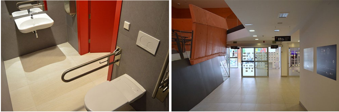
Servizio igienico accessibile con lavabo integrato nella stessa cabina e con fasciatoio per neonati./ Porte automatiche.
