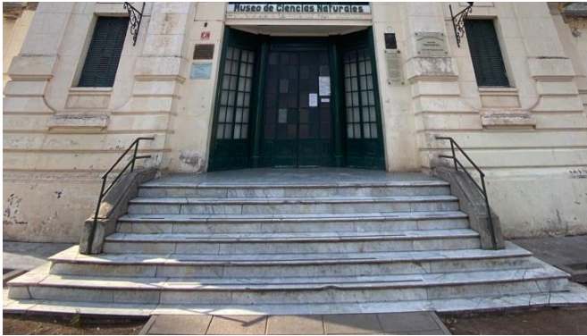
Ingresso pedonale originale non accessibile.
