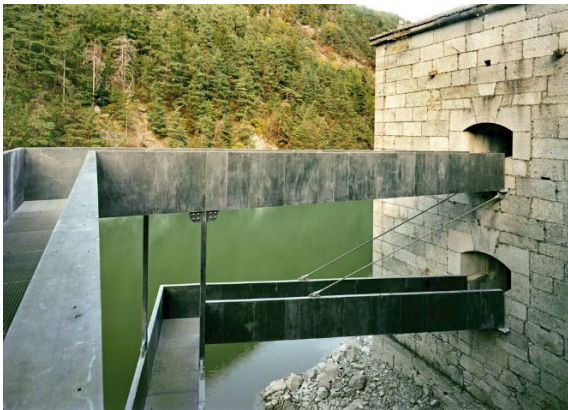
Forte di Fortezza. Bolzano, Italia. Arch. Markus Scherer & Karl Dietl (2005-2009)
