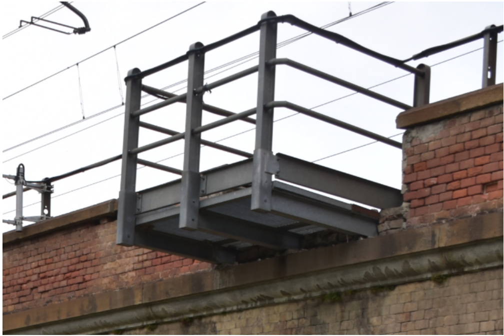
Figura 3.22: Realizzazione piazzole di rifugio a sbalzo
