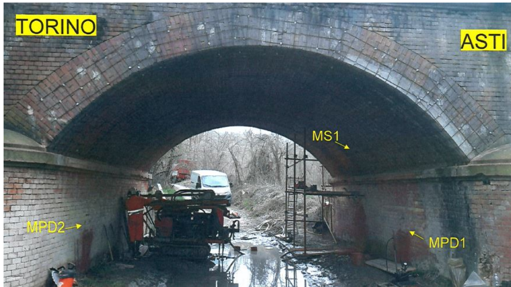
Figura 3.37: Ubicazione delle prove con martinetti piatti
