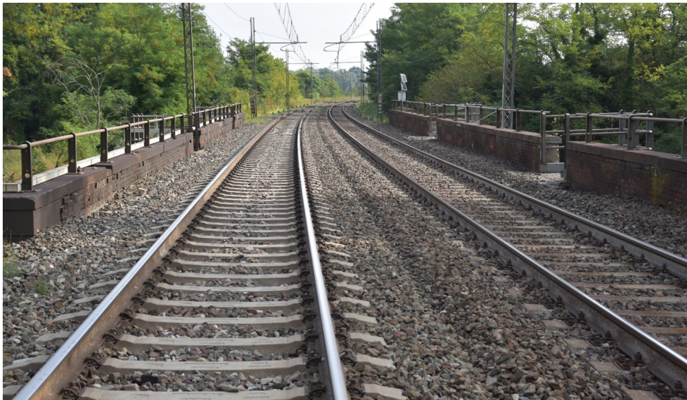
Figura 3.24: Stato della sovrastruttura ferroviaria (direzione Genova)
