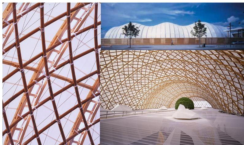
Figura46\_struttura del guscio del Japanese Pavillion in tubi di cartone
