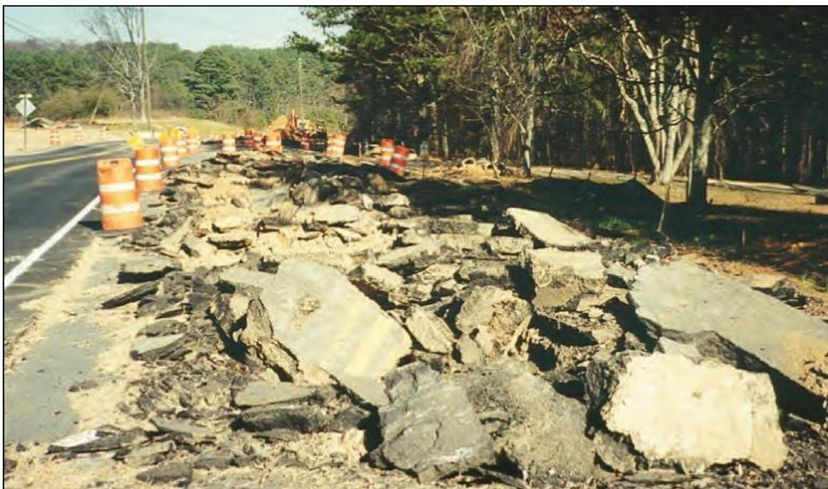
Figura 3.1.3 - Macerie di una pavimentazione da demolizione completa di una carreggiata (<https://www.asphaltpavement.org/>).
