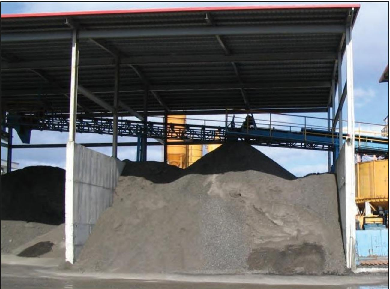
Figura 3.3.6 - Protezione dei cumuli di RAP all'interno di strutture apposite (<https://www.asphaltpavement.org/>).
