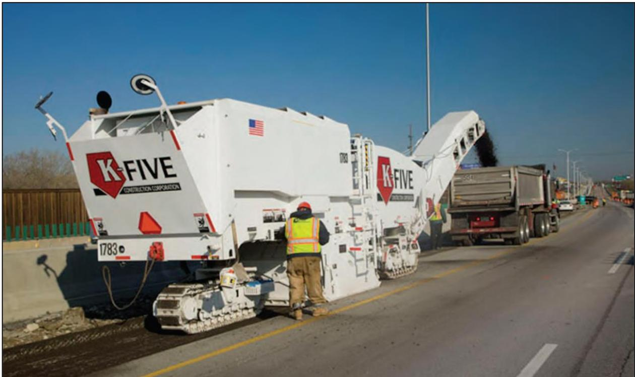
Figura 3.1.1 - La fresatrice rimuove gli strati della pavimentazione come parte del suo ripristino (<https://www.vaasphalt.org/>).
