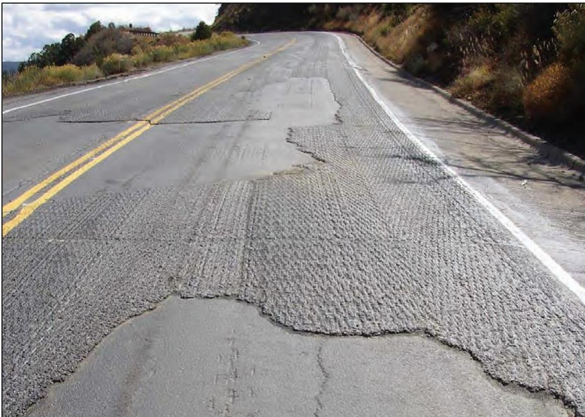
Figura 3.1.2 - Superficie della pavimentazione fresata con uno strato sottile di crosta che potrebbe provocare un cedimento prematuro del rivestimento (<https://www.asphaltpavement.org/>).
