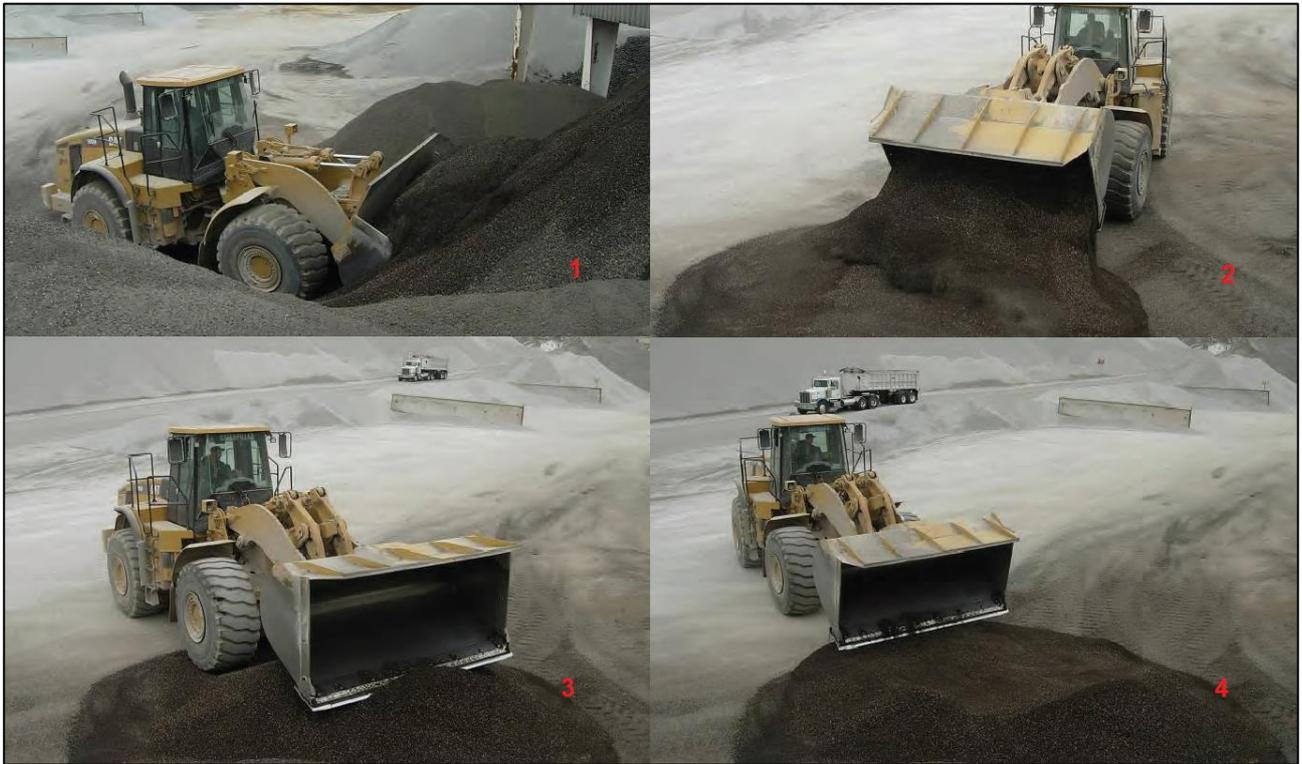
Figura 3.4.2 - Step per campionare correttamente il RAP (1, <https://www.asphaltpavement.org/>).
